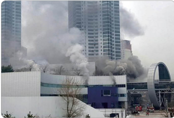
상가 매장 복구공사 중 화재 ('17.2.4. 사망 4, 부상 47)
