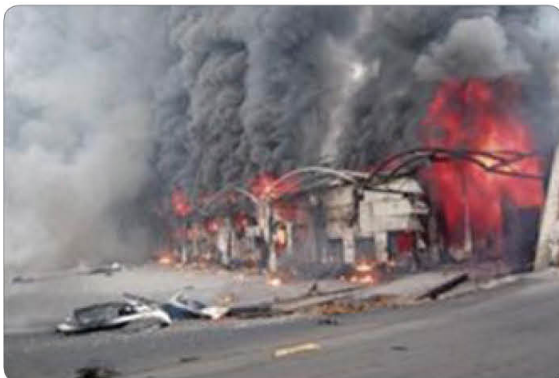
미천 물류 냉동창고 신축공사 화재 ('08.1.7. 사망 40, 부상 10)
