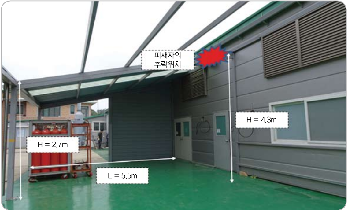
재해발생 현장 전경
