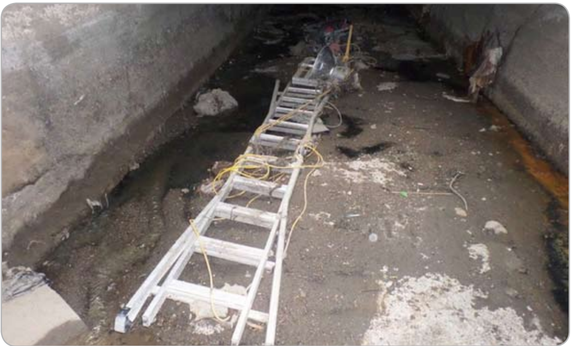
사고발생 현장 전경
