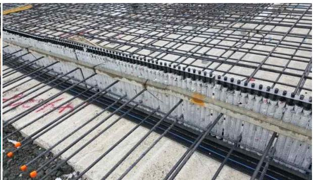
그림 3-14. 기성재 PVC 콘크리트 타설막이 설치
