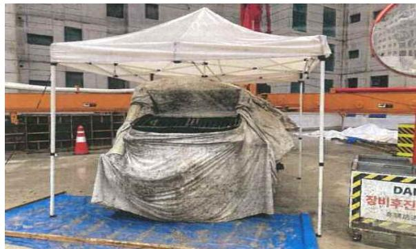
그림 3-11. 펌프카 호퍼외부 천막 설치 예시
