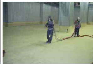
냉동창고 벽면·바닥 스프레이 시공
