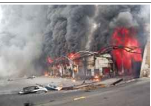
이천 물류 냉동창고 신축공사 화재 (*08.1.7 사망40, 부상10)
