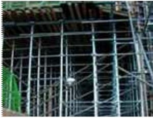
▶ **(거푸집 동바리)** 거푸집 동바리의 구조검토를 실시하지 않거나 설계도면 대로 설치하지 않아 콘크리트 타설 중 거푸집이 무너져 콘크리트 더미에 매몰되어 사망
