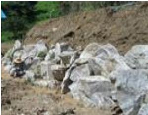
▶ (사면 및 암반) 굴착 사면의 적정 기울기를 준수하지 않고 작업 중 토사가 무너지면서 사면 및 암반 더미에 깔려 사망
