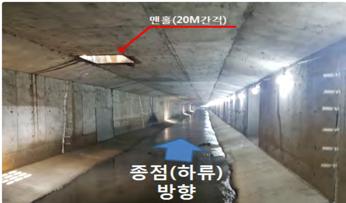
[사진1] 재해발생 현장 내부 전경
