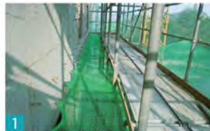
강관비계 설치 사례
