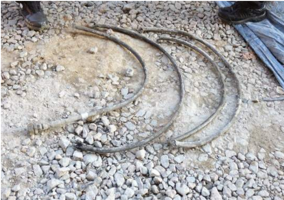
12. 파열된 고압호스 잔해 전체
