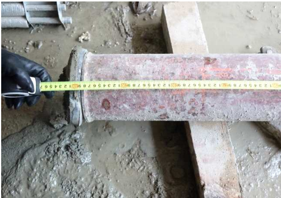
22. 압송용 배관 길이 측정 / 3m
