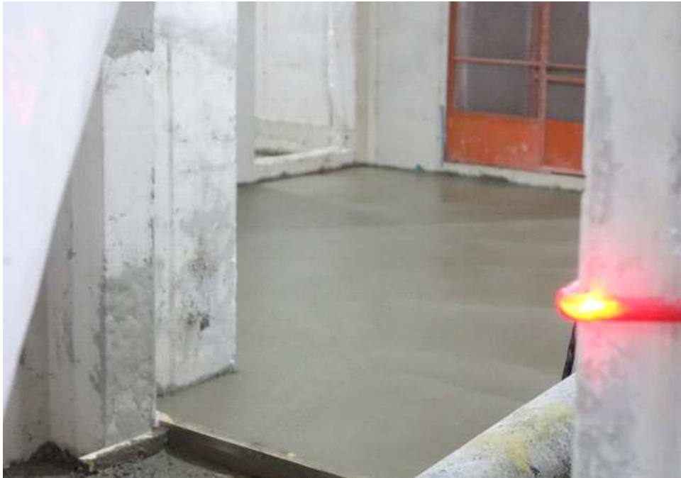
7. 국회 스마트워크센터 공사현장 내부 / 콘크리트 타설장소
