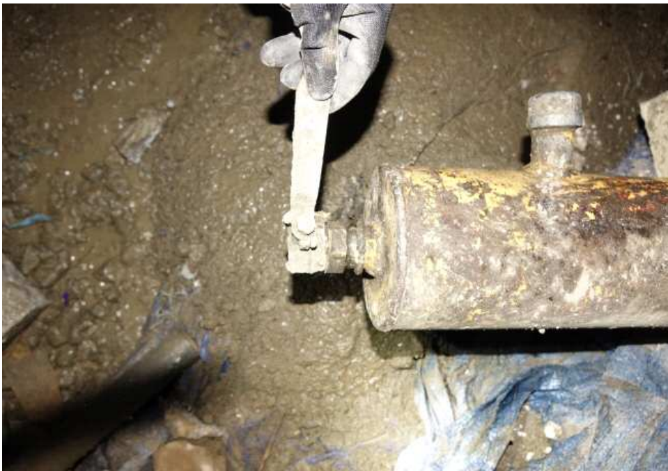
20. 중간밸브 설치 재연 / 잠금상태
