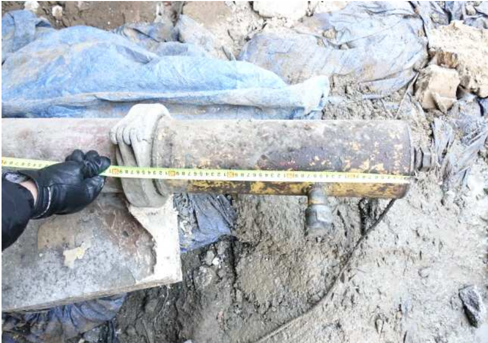
23. 중간밸브 연결용 배관 길이 측정 / 약 45cm
