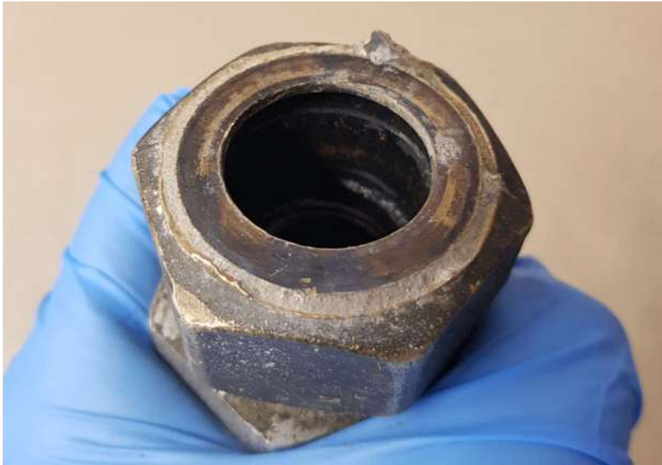
29. 중간밸브 파손형태 / 관연결부
