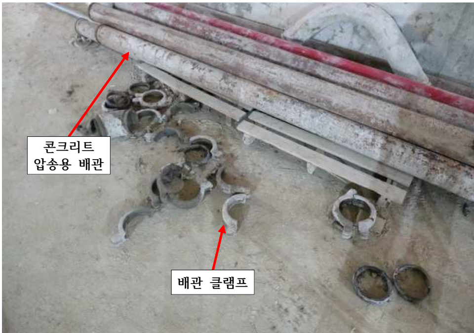
6. 국회 스마트워크센터 공사현장 내부 / 배관 및 클램프
